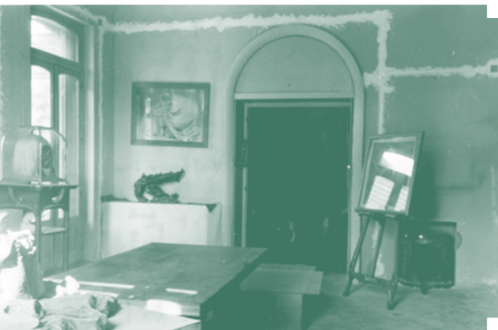
④ Salle du 1 er étage, en travaux, vers 1963-1966.
