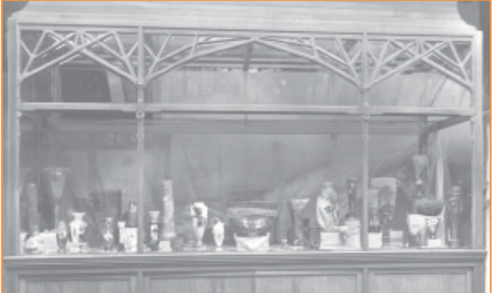
Exposition universelle de 1900. Vue de la vitrine Repos dans la solitude . Tirage moderne d’après plaque de verre offert par M. et Mme Jean Bourgogne (inv 994.20.1).
