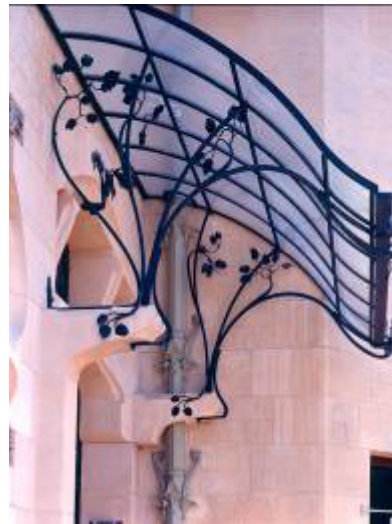
Villa Majorelle, détail de la marquise de la porte d'entrée
