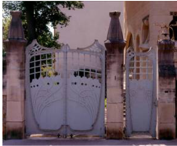
Villa Majorelle, Portes cochère et piétonne, Cliché P. Mignot
